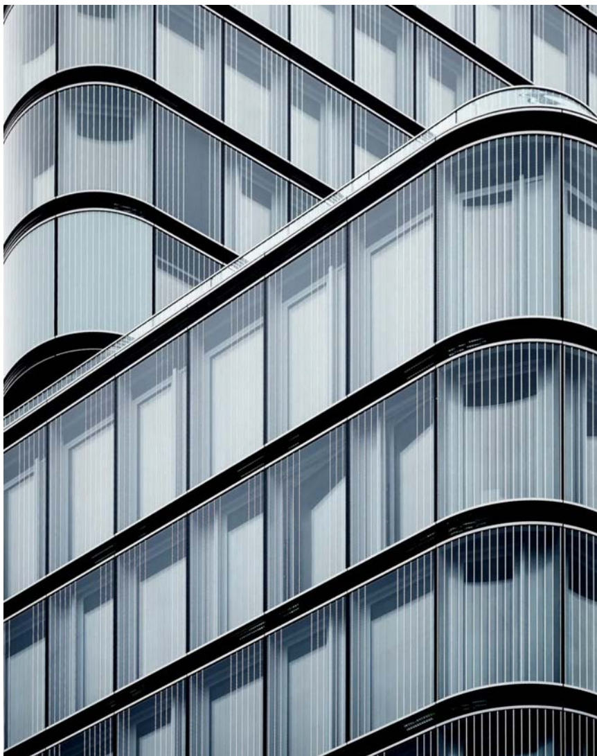
Bild 3: Projekt: Porsche Design Tower, Stuttgart Architekt: Bülow AG, Porsche Design Group Prallscheibe: arcon sunlight® grey 65 oHT ORNILUX® design lines
