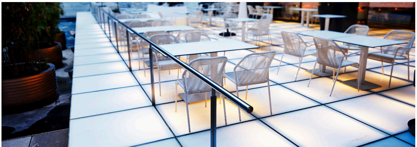
Begehbarer Terrasse aus Verbundsicherheitsgläsern im Restaurant Amici, Stuttgart.
