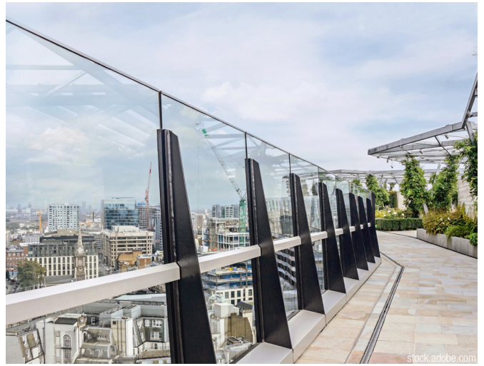
Absturzsicherndes Glasgeländer auf einem Hausdach.
