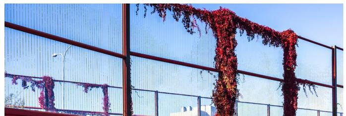
Bei ORNILUX® design wird erstmals ein neues Beschichtungsverfahren angewandt, welches das bisher eingesetzte Siebdruck-Verfahren ergänzt. Durch die sichtbaren Markierungen nehmen Vögel das Glas als Hindernis wahr. ORNILUX® design ist in den Varianten dart 9-90 und lines 5-95 erhältlich.
